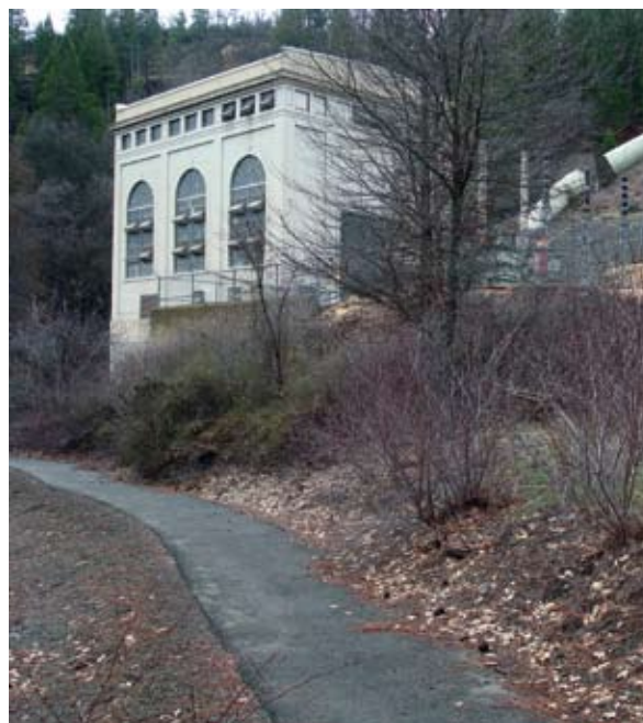
PG&E Hat Creek Powerhouse
